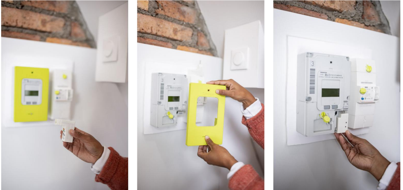
Figure 2: Installing an ERL
